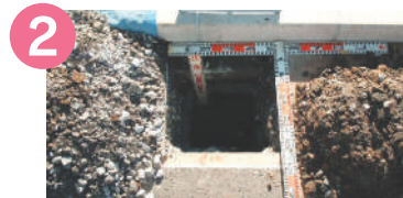
底盤石・コンクリート杭を埋める為の穴を掘る。
