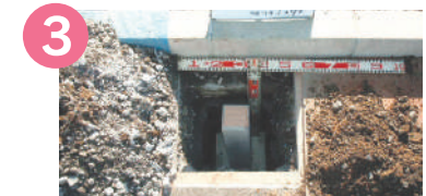
底盤石・コンクリート杭を設置する。
