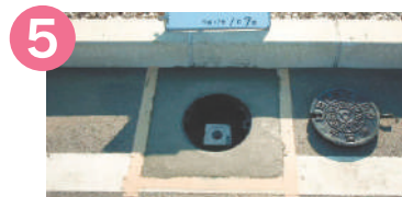
周辺をコンクリート等で舗装する。
